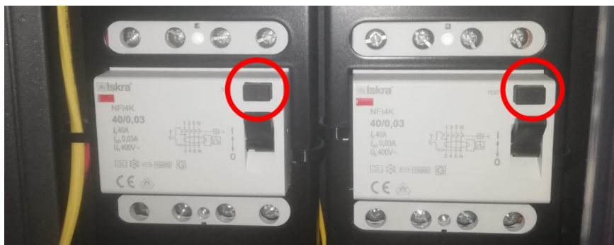
Figura 3: pulsante di test RCD
