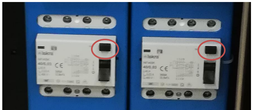
Figura 2: pulsanti di test RCD
