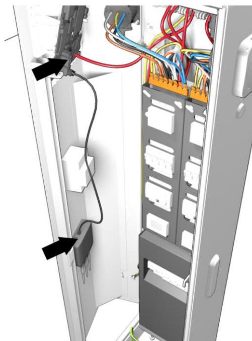
Figura 25: collegamento dei cavi UTP
