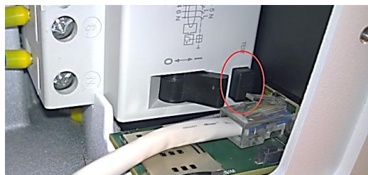
Slika 34: Dugme za testiranje FID prekidača (RCD)
