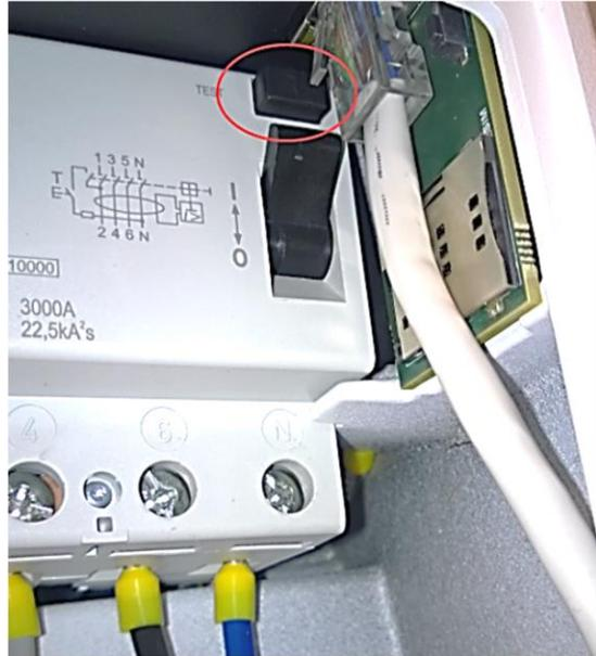
Figura 42: Botão de teste de RCD
