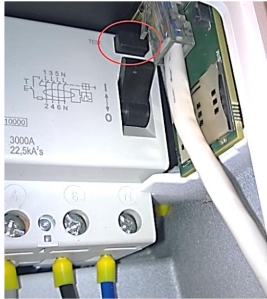
Rysunek 42: Przycisk testowy urządzenia RCD
