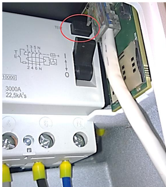
Abbildung 43: Prüftaste des Fehlerstromschutzschalters (RCD)
