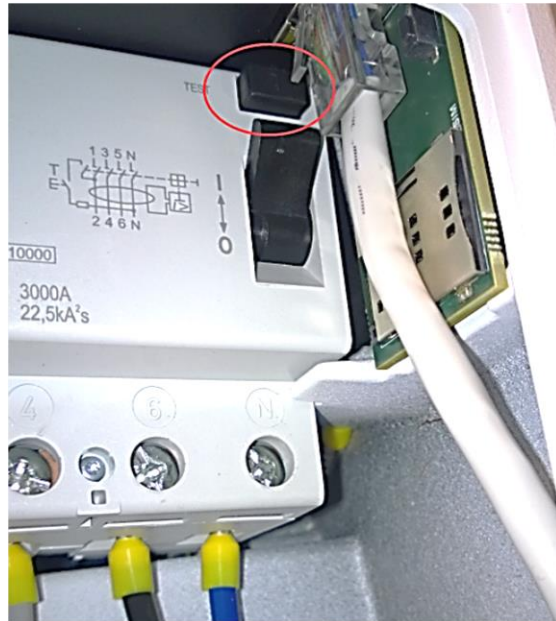
Figura 43: Pulsante di test RCD
