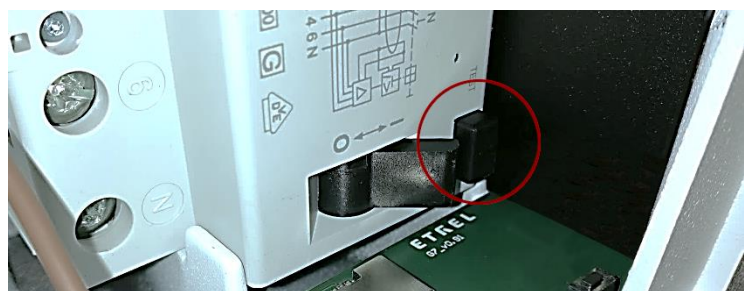
Figur 5: Testknapp för RCD
