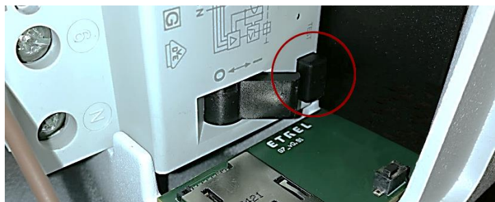
Slika 5: Gumb za testiranje FID stikala (RCD)
