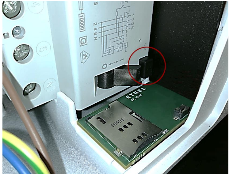
Slika 5: RCD test tipka
