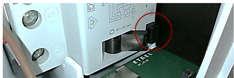
Abbildung 11: FI Schalter-Testtaste
